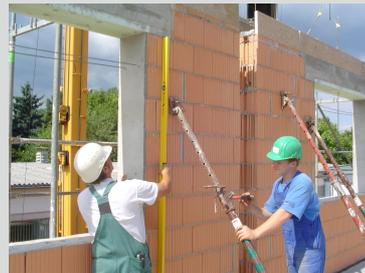
Damit die Montage von Dachgeschosswänden und Giebelspitzen erleichtert wird, sind gut sichtbare Montagemarkierungen an den Wänden angebracht. Ein passgenaues Montieren ist problemlos möglich.
