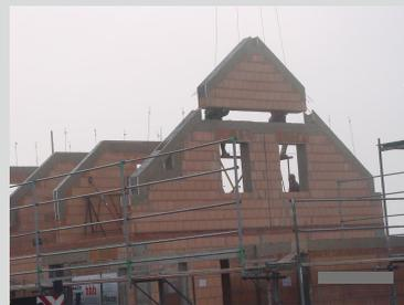
Restarbeiten, sobald die Standsicherheit der Mauertafeln z.B. durch Deckenauflage, Ringanker u.s.w. dauerhaft gewährleistet ist:
